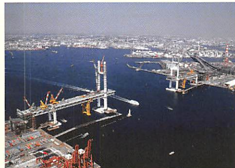
建設工事中の 横浜ベイブリッジ 1987（昭和62）年 主塔と橋桁の建設工事の様子 当館蔵
